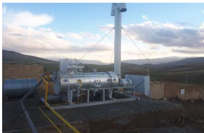
(شکل ۴) نمایی از گرمکن ایستگاه تقلیل فشار
