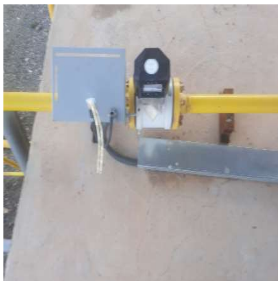
(شکل ۵) نمایی از کنتور اندازه گیری میزان سوخت تغذیه هیتر کامپاران
