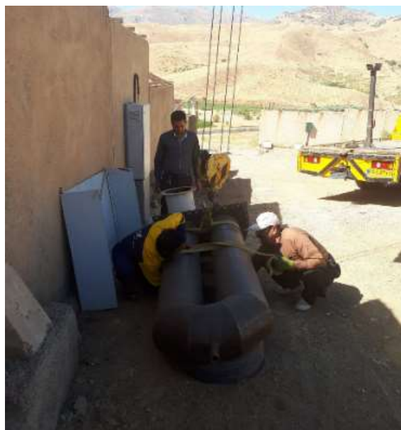
(شکل ۷) تصویر آتشدان گرمکن ایستگاه تقلیل فشار ماویان
