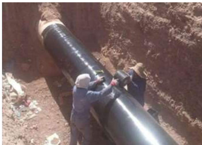
شکل(۳): تعویض پوشش لوله انتقال مارون - اصفهان و کشیدن پوشش پلی اتیلن بر روی آن
