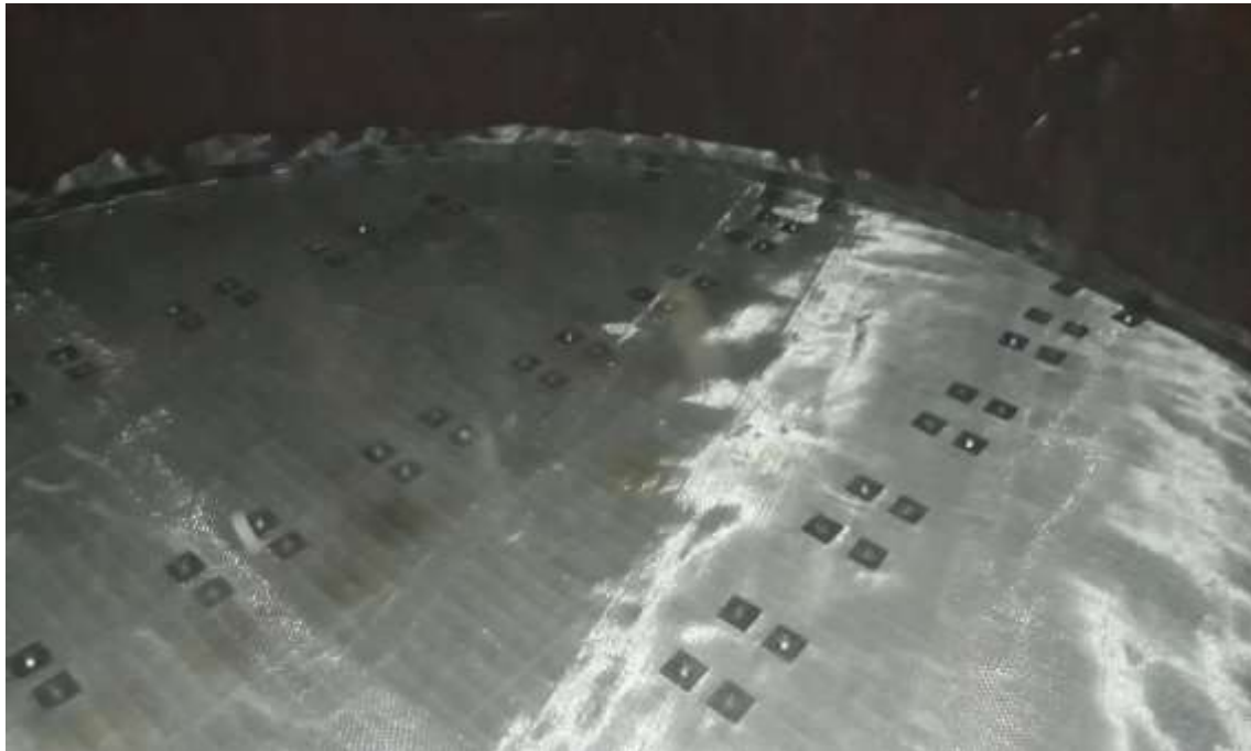
تصویر (۱۲) پیچ و مهره کردن مش ها به ساپورت گرید
