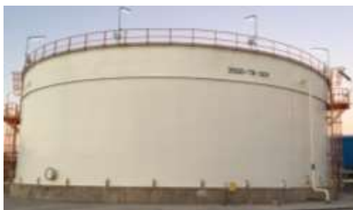
شکل ۱ - مخزن ذخیره نفت حفاظت شده با سیستم حفاظت کاتدی اعمال جریانی
